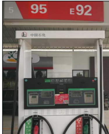
图 4-2 加油机、油气回收装置
